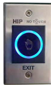
ตัวอย่างปุ่มกดเพื่อปลดล็อกประตู แบบ Infrared
